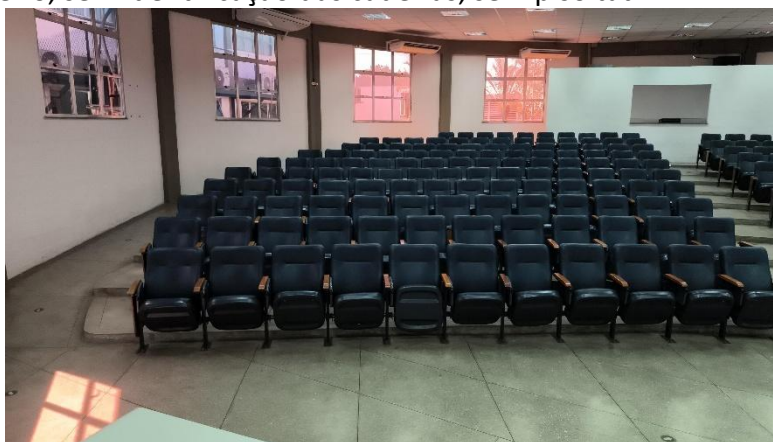
Figura 79 - Auditório sem piso tátil e sem demarcação dos assentos para PCDs
