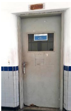
Figura 47 - Laboratório sem maçaneta tipo alavanca
