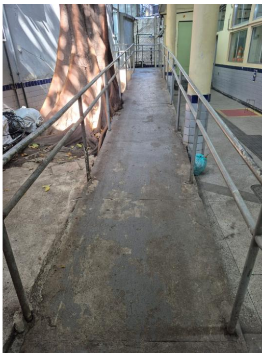
Figura 61 - Rampa sem piso tátil na entrada e saída do Departamento de Tecnologia da Informação (DTINF)
