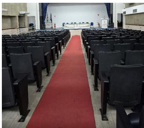
Figura 15 - Ausência de piso tátil no corredor
